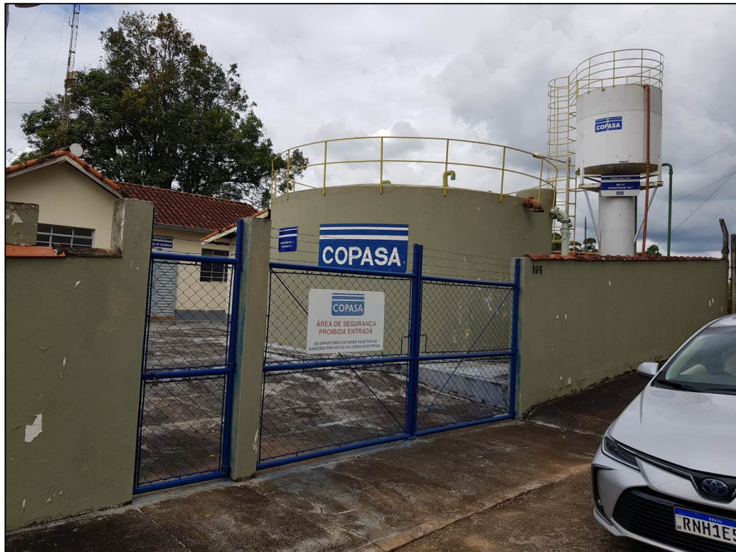
Foto 39 - São Gonçalo - Vista geral - Escritório, unidade de tratamento de água
