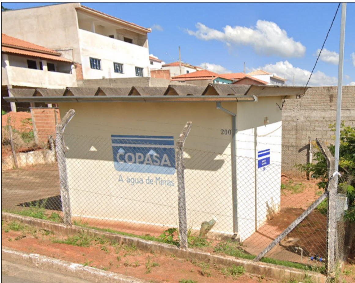
Foto 31 - Booster Serra Verde - Vista externa
