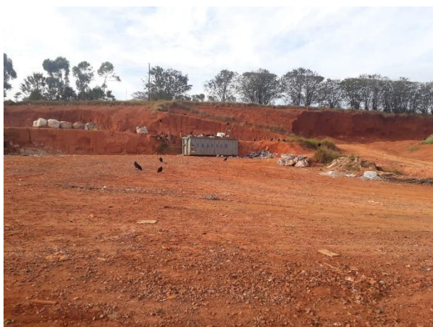
Figura 7. Vista do posicionamento da caçamba tipo roll on
