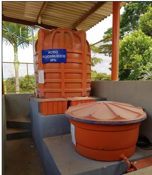
Foto 17 - ETA - Botelhos - Tanques de armazenamento e preparo de ácido fluossilícico
