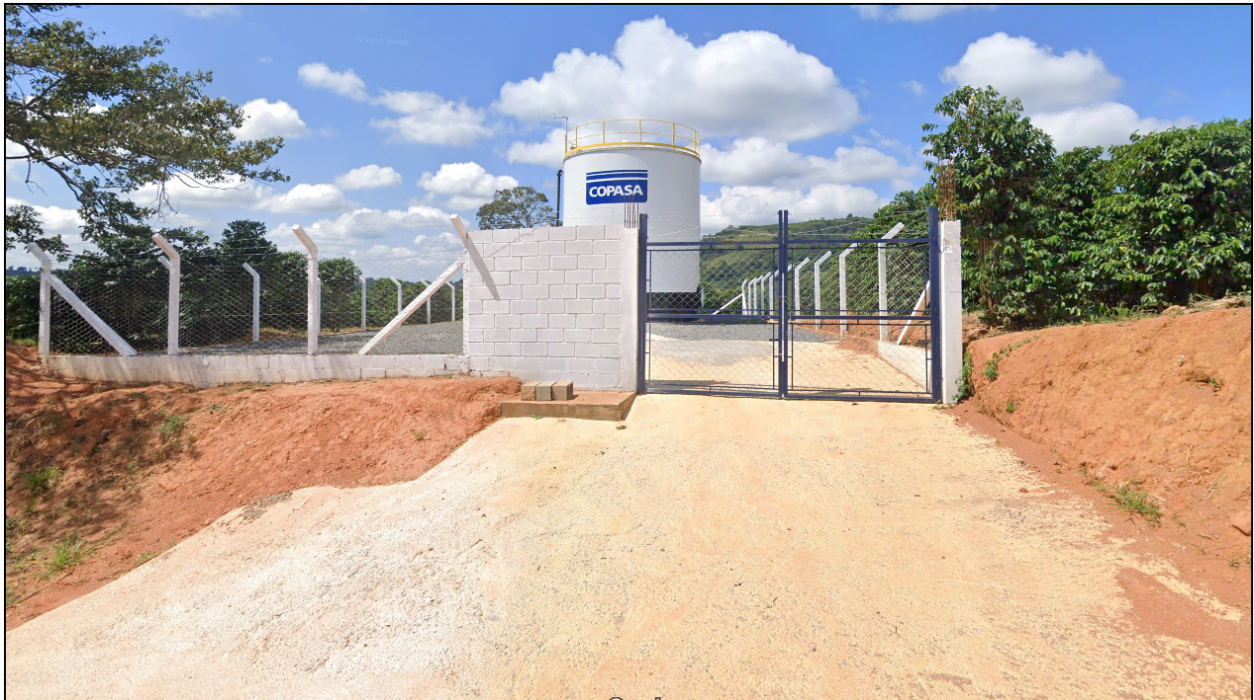
Foto 29 - Reservatório associado ao Empreendimento 1
