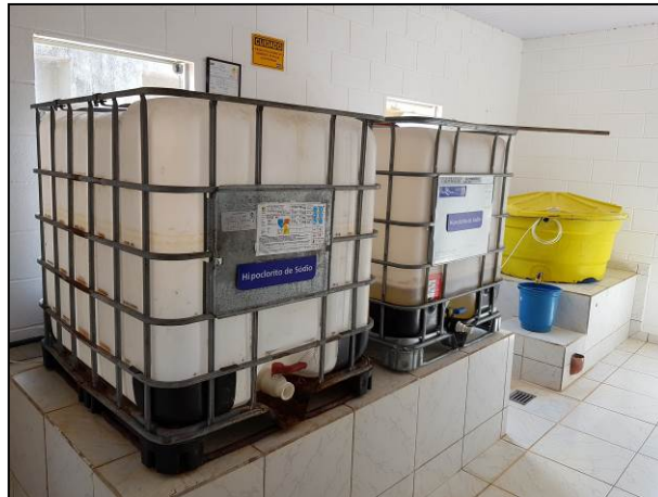
Foto 17 - ETA - Botelhos - Tanques de armazenamento e preparo de ácido fluossilícico
