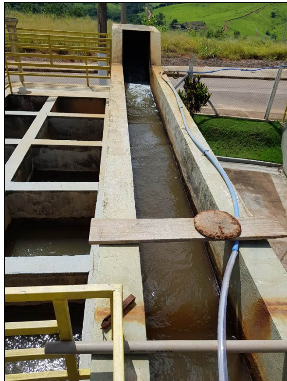
Foto 11 - ETA - Botelhos - Canal de entrada
