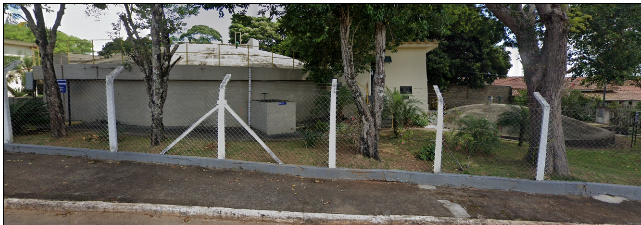
Foto 24 - Centro de reservação próximo à ETA
