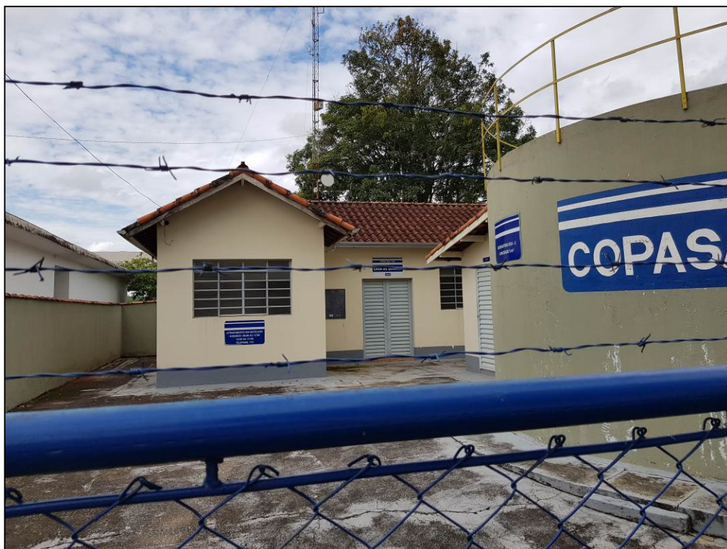
Foto 40 - São Gonçalo - Unidade de tratamento de água e EEAT I
