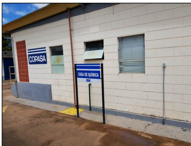
Foto 20 - ETA - Botelhos - Vista geral do laboratório
