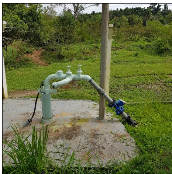
Foto 6 - Poço E02 - Botelhos
